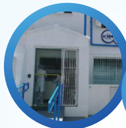
Fachada com rampa e estacionamento.
